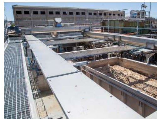
Conjunto transportadores canal con revestimiento de polietileno y eje hueco
