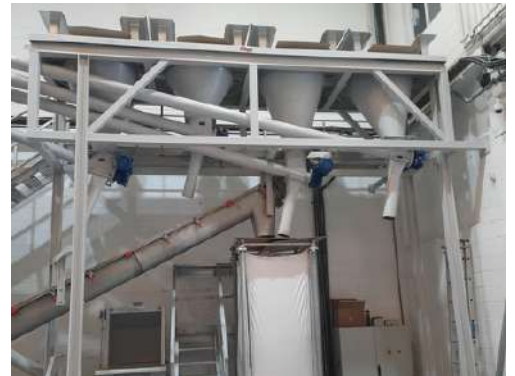
Conjunto transportador canal, descargadores de big bags y transportadores sinfín
