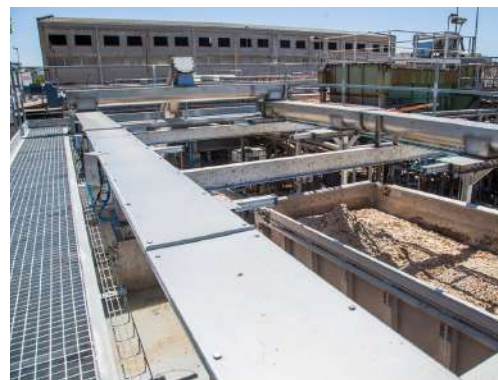
Conjunt transportadors canal amb revestiment de polietilè i rosca amb eix buit
